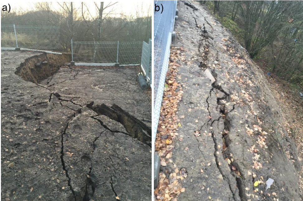
Rys. 8. Widok a) osuniętych mas w koronie skarpy; b) skarpy wzdłuż ogrodzenia działki.
